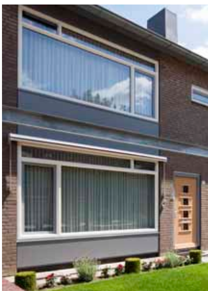
Renovatie van jaren '70 woning
